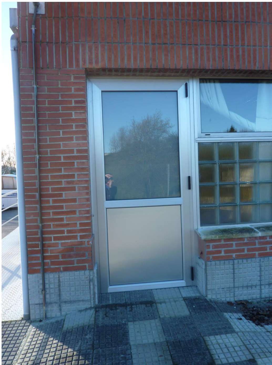
Foto exterior de la salida de emergencia
