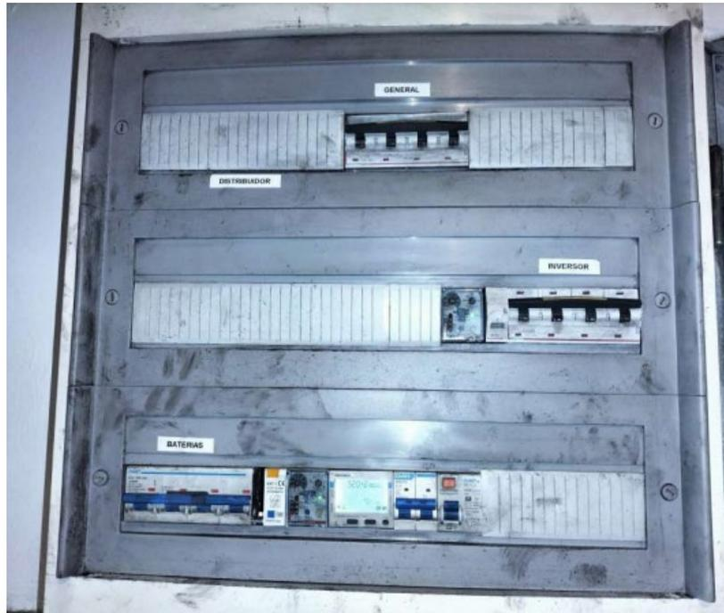
Desde este cuadro se ha tendido una línea al cuadro de la instalación existente con cable ES07Z1-K 4x35mm<sup>2</sup>+TT, y dotando al cuadro general de una protección de 4x100A.
