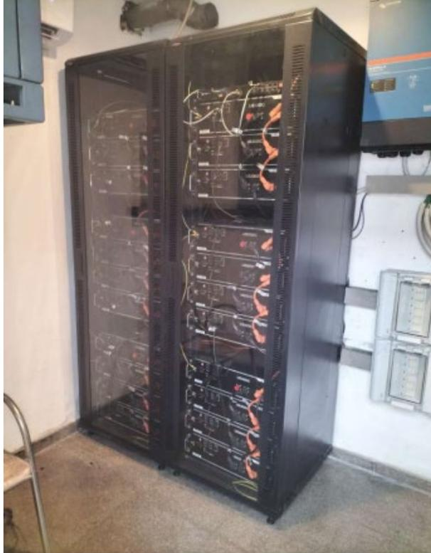
Las baterías disponen de sus fusibles de protección de 125 amperios y embarrados de continua.
